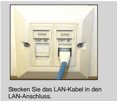
Stecken Sie das LAN-Kabel in den LAN-Anschluss.
